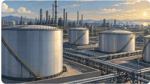
炼油厂的储油罐区
