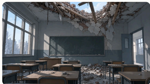
事故后的教室示意：破损屋顶下，只剩空课桌
